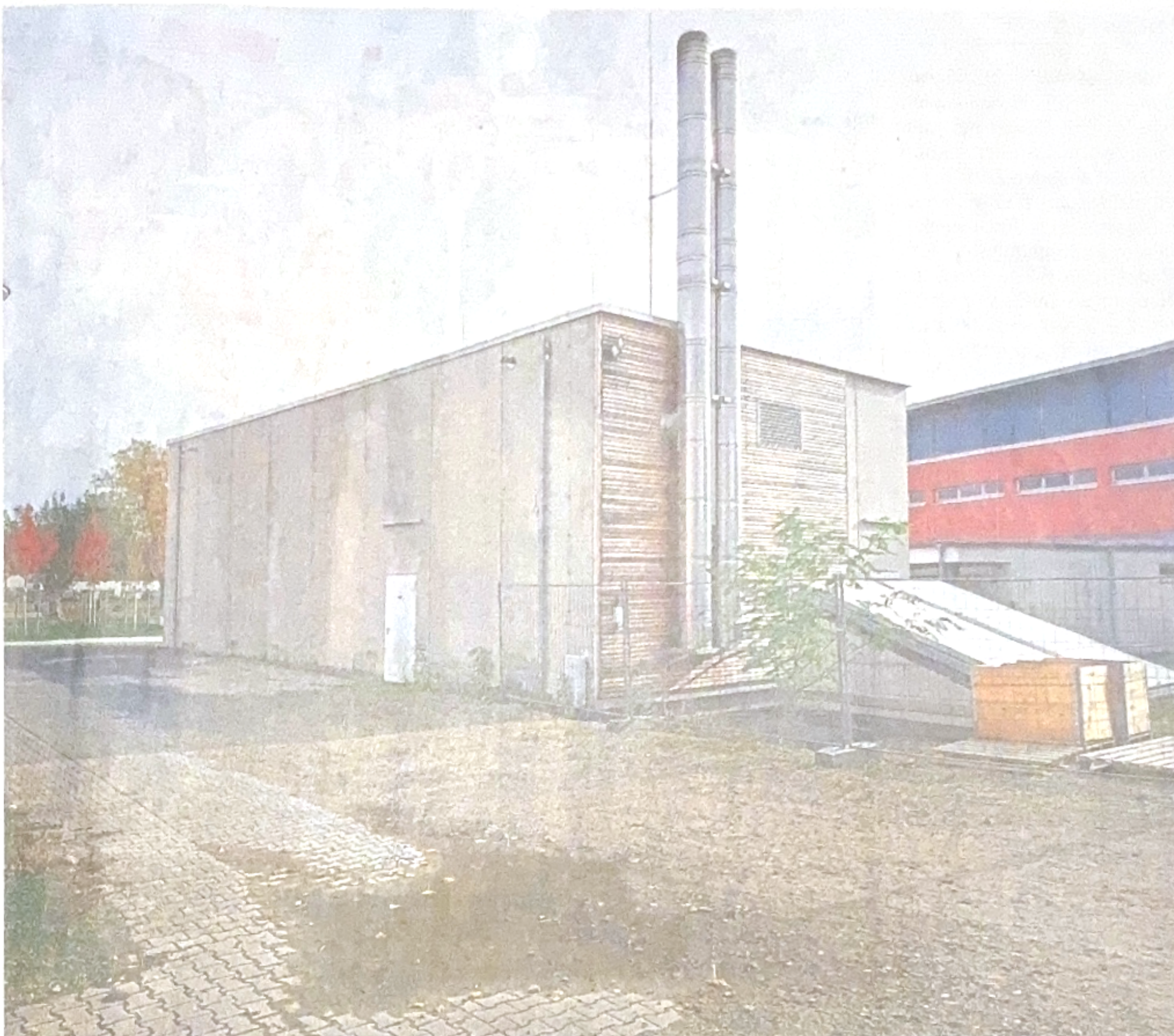
Vorbildfunktion für die geplante Heizzentrale der BERMeG in Mörfelden hat die bestehende Einrichtung im Stadtteil Walldorf (Foto). Dort wird die Wärme aus erneuerbaren Energien wie Biomasse (Holzhackschnitzeln) und Solarthermie gewonnen – und das ist auch beim zweiten derartigen Projekt der Energiegenossenschaft geplant.
